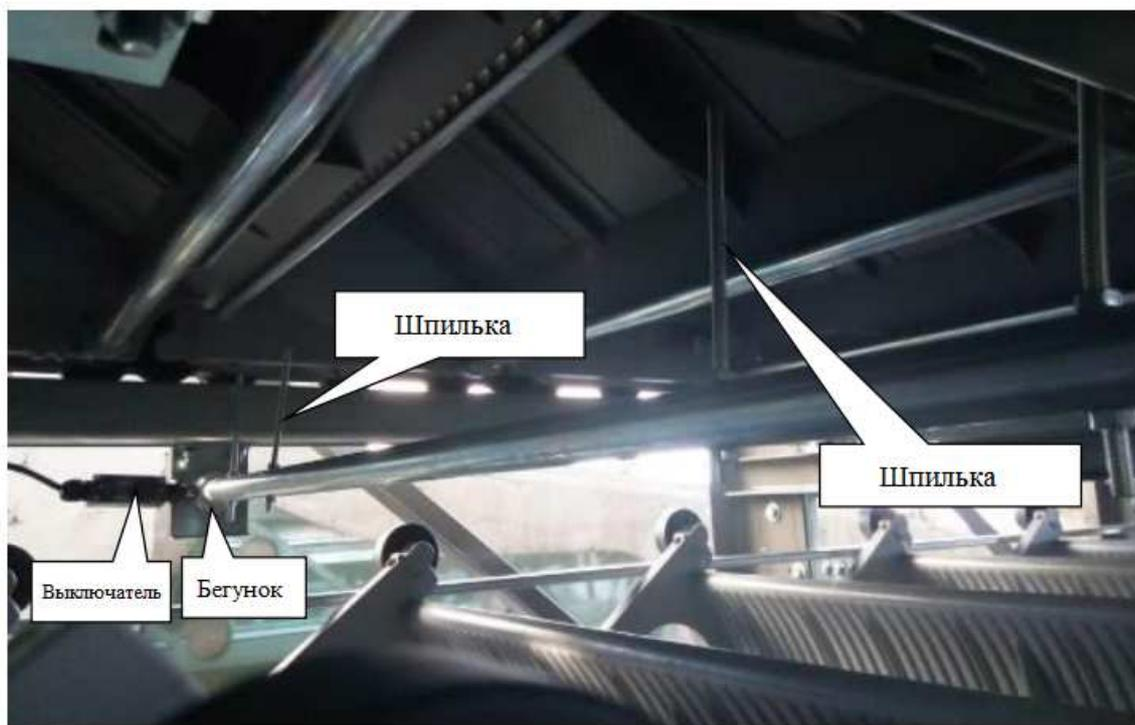
Рисунок 1.64 – Фото расположения выключателя безопасности цепи.
