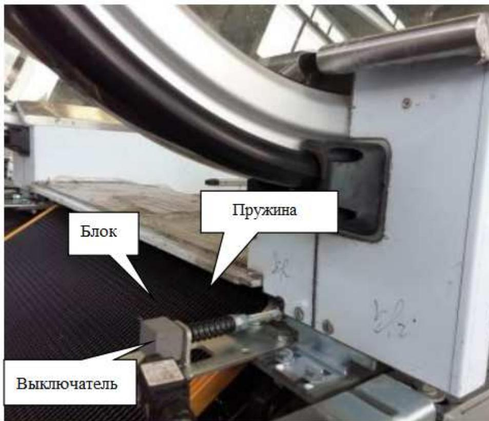
Рисунок 1.74 – Регулировка защитного устройства гребенки (фото).
