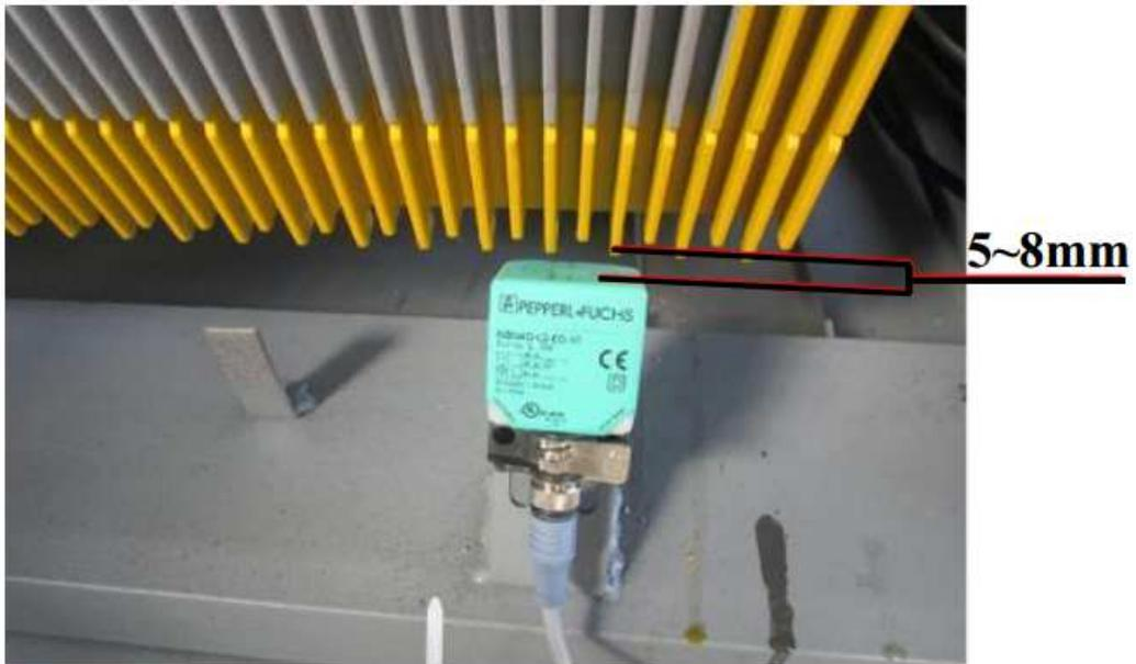
Рисунок 1.65 – Фронтальный датчик отсутствия ступени/паллеты (фото для справки).
