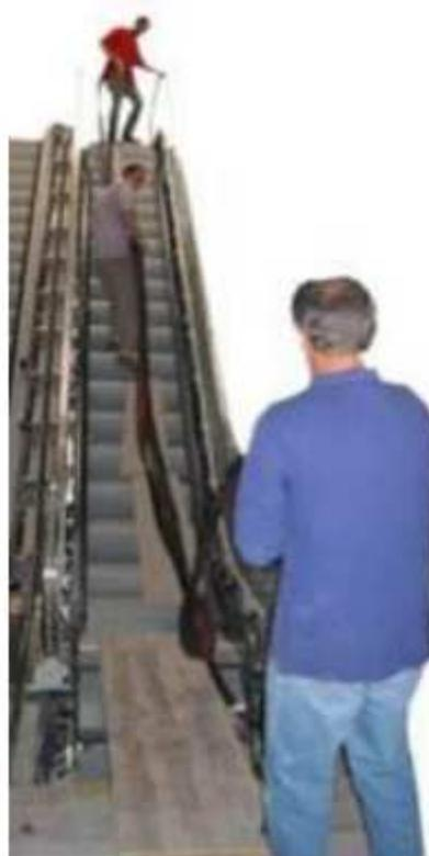
Рисунок 1.52 – Монтаж поручня.
